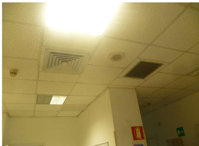
Particolare impianto diffusione aria - uffici
