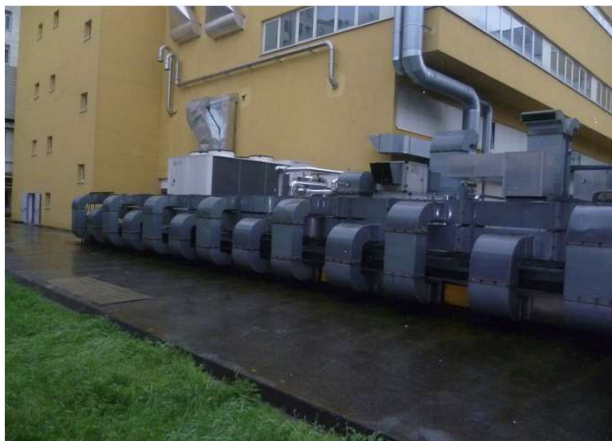
Particolare canalizzazioni mandata/ripresa camera mortuaria
