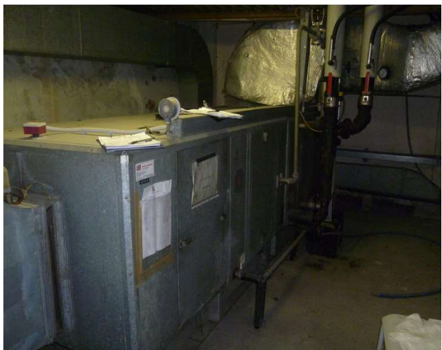
Particolare sezione di mandata
