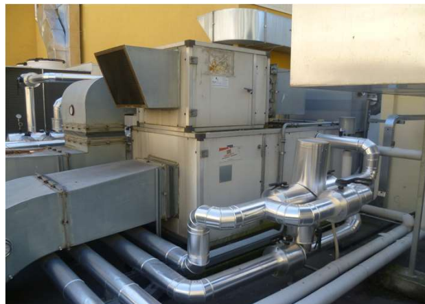
Particolare unità di trattamento aria
