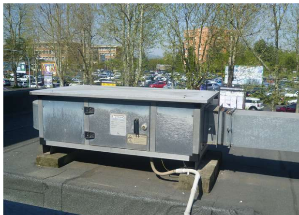
Particolare ventilatore di mandata Sala Settoria
