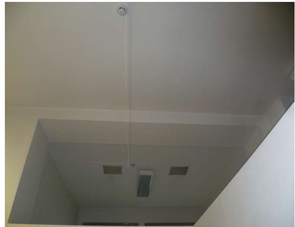
Particolare griglie di areazione in controsoffitto non ispezionabile
