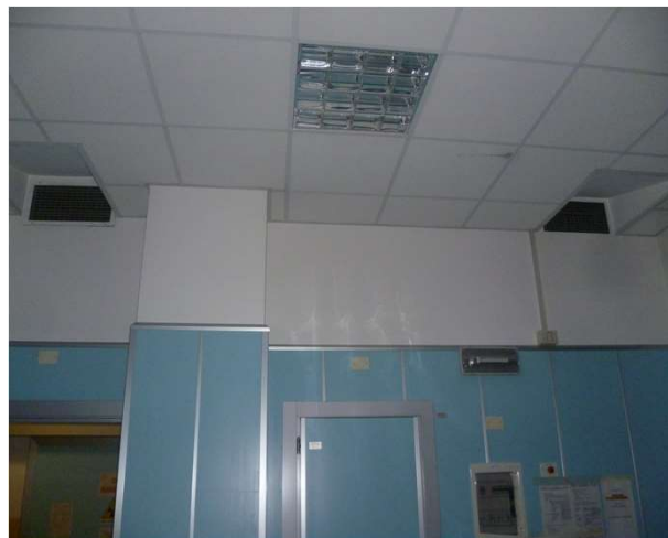
Particolare controsoffittatura locali
