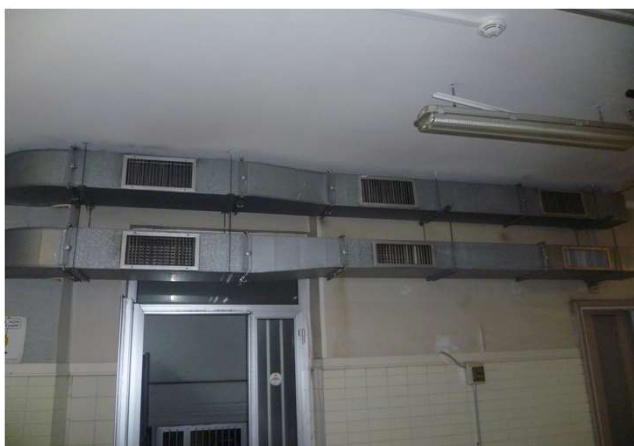
Particolare canalizzazioni a vista Sala Settoria
