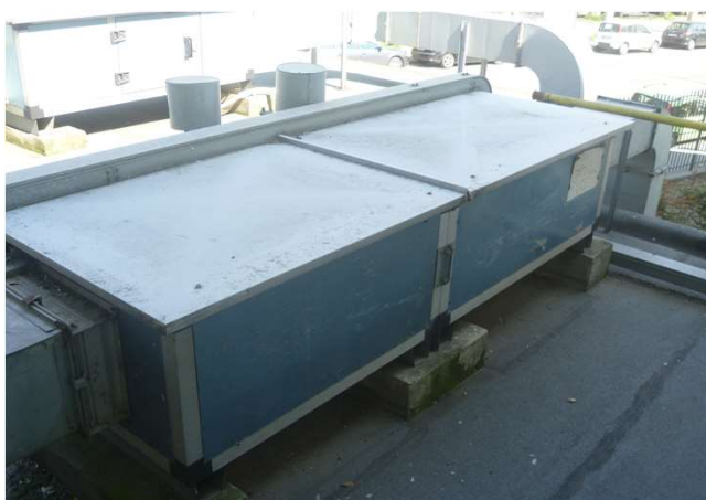
Particolare ventilatore di ripresa Sala Settoria
