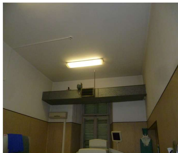
Particolare canalizzazioni interne a vista
